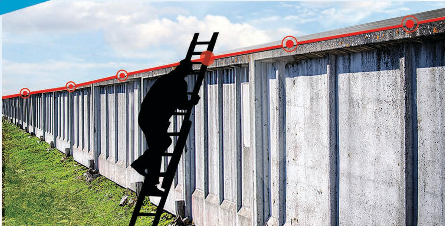
高价值设施的周界墙壁部分或全部为砌石墙。监控越过周界的入侵行为是周界保护计划的一个重要部分。
